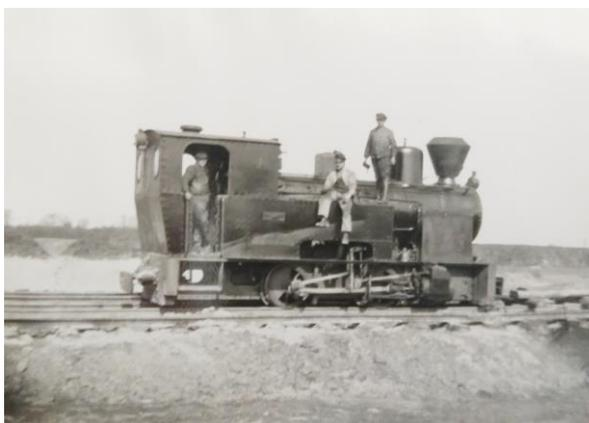
Eine der Lokomotiven mit den Arbeitern für den Abtransport des (zumeist sandigen) Aushubs zur Kippe
