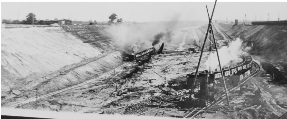
Kanalbauarbeiten 1930: im Kanalbett Lokomotiven, Loren und Gleise zum Abtransport zu den Kippen (weit im Hintergrund). Vermutliche Kameraposition: westlich der späteren Straßenbrücke, Blick Richtung nach Südwest, links Baubaracken, in der Mitte links das Alte Försterhaus, rechts die Wedelheiner Kanalseite. Die Fußgängerbrücke ist noch nicht gebaut. Nicht mit erfasst sind dann links die Gebäude zur alten Wassermühle ("Tante Ida", "das Schäferhaus") bzw. rechts die Molkerei Gustav Köstel.
